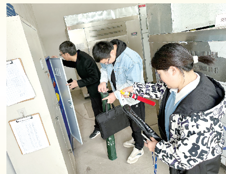
近日,临港开发区安委办工作专班到河南省益常青生物科技有限公司开展安全生产督导检查,重点对企业有限空间、配电室等进行检查,防范化解安全风险。记者宋风摄
