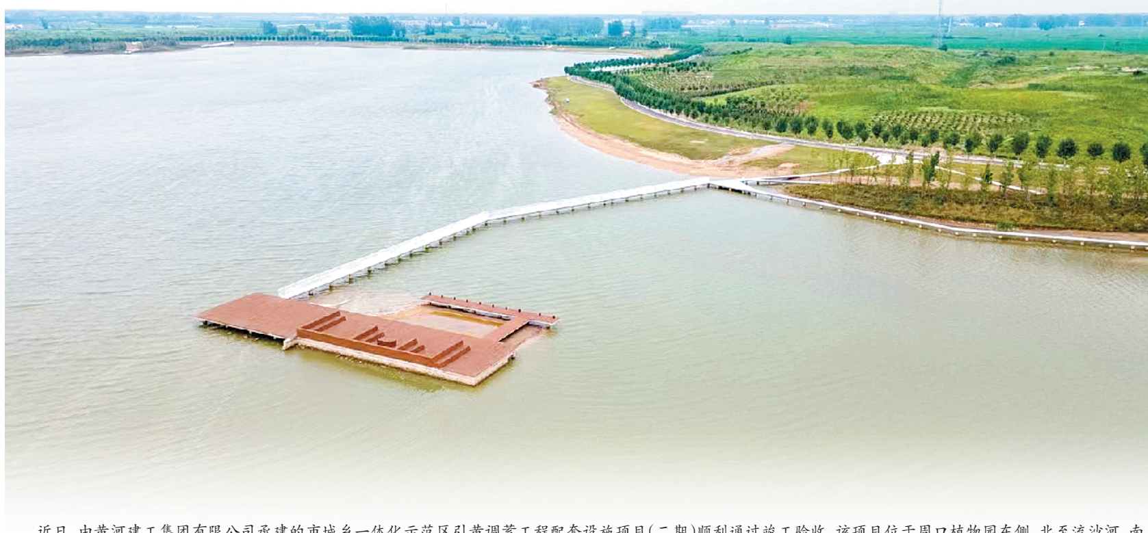
近日,由黄河建工集团有限公司承建的市城乡一体化示范区引黄调蓄工程配套设施项目(二期)顺利通过竣工验收。该项目位于周口植物园东侧,北至流沙河、南至环湖南路,东接高铁东线,包括游船码头、栈道及亲水平台、湖内绿化及生态岛等。
