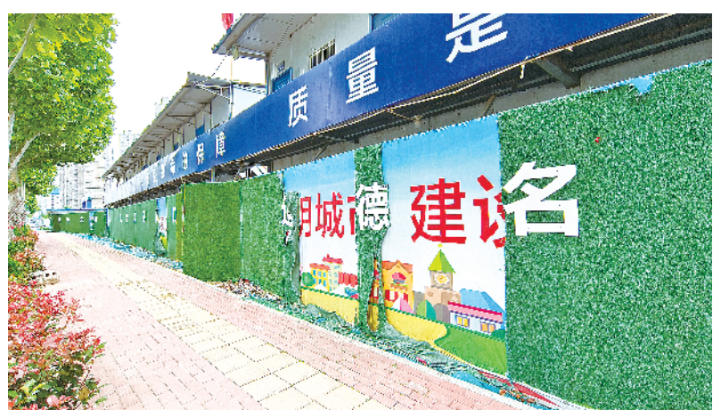
5月12日,记者在湘江路采访发现,道路边部分围栏上的宣传广告有破损现象,亟待更换。记者 刘俊涛 摄
