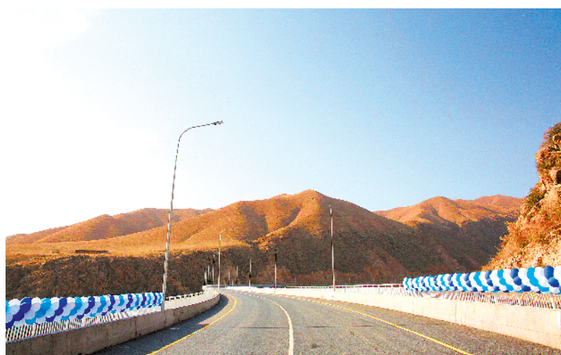
这是2021年11月10日拍摄的吉尔吉斯斯坦新北南公路二期工程的一座大桥。罗曼 摄(新华社发)
