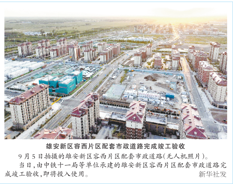
雄安新区容西片区配套市政道路完成竣工验收 9月5日拍摄的雄安新区容西片区配套市政道路(无人机照片)。 当日,由中铁十一局等单位承建的雄安新区容西片区配套市政道路完成竣工验收,即将投入使用。 新华社发
