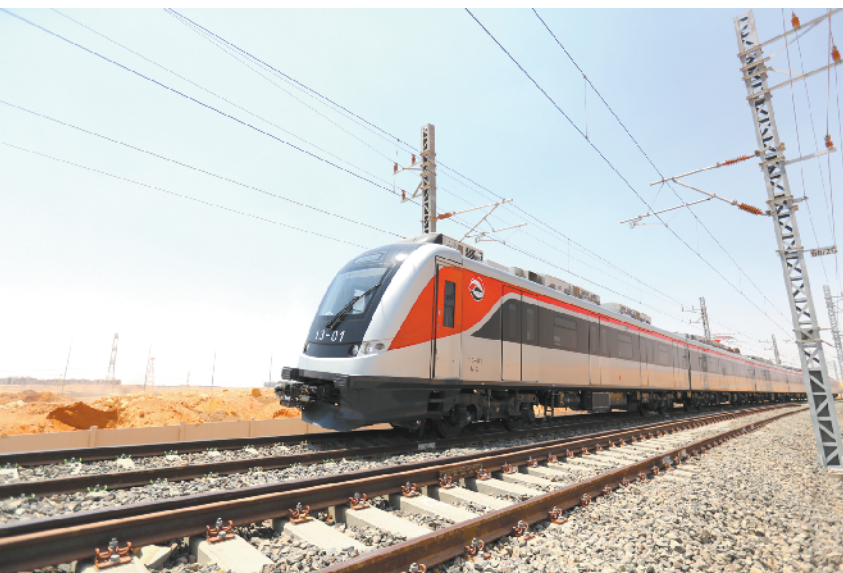
这是7月3日在埃及开罗东部拍摄的一列驶向埃及新行政首都方向的试运行轻轨列车。 由中国企业承建的埃及斋月十日城轻轨铁路3日通车试运行,这是埃及第一条电气化铁路。埃及斋月十日城轻轨铁路位于埃及首都开罗东部,是连接开罗市区与新行政首都、斋月十日城和东部沿线卫星城的重要纽带,也是中埃“一带一路”合作旗舰项目之一。新华社记者 隋先凯 摄
